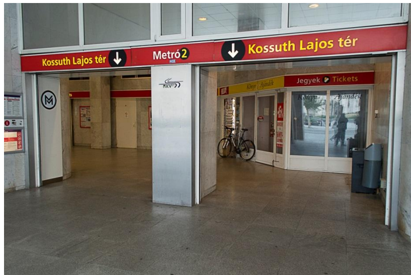
22. ábra Kossuth tér állomás (Duna felőli bejárat) (Fotó: Gelencsér Ádám)
